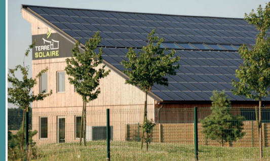
v Terre solaire (27) Bâtiment avec toiture photovoltaïque
